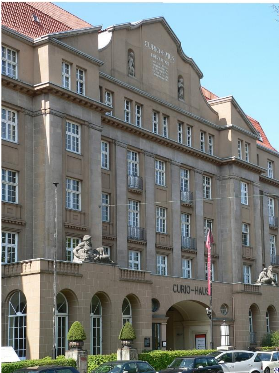
„Curio Haus” w Hamburgu (fot.: stan obecny), w którym toczył się proces.
